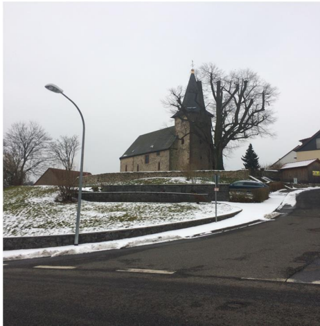
Bild 3: Martinskirche mit Wehrmauer und Linde.
